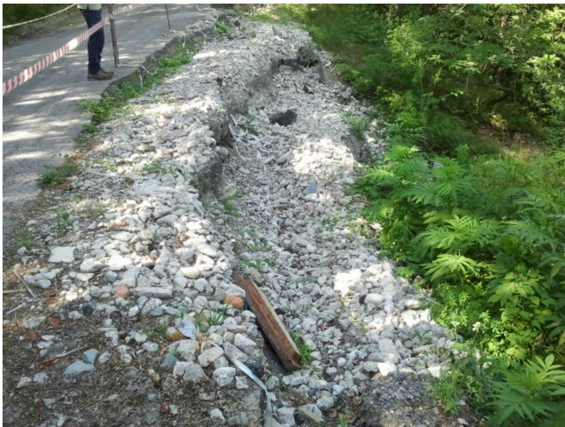
Fig 6. Particolare della nicchia in strada
